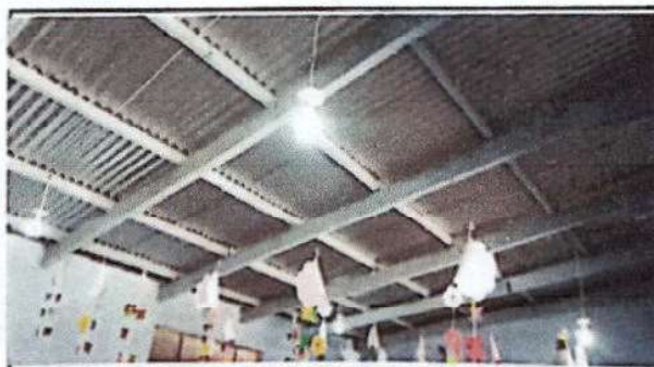
Foto 6: Cableado del sistema eléctrico arreglados
